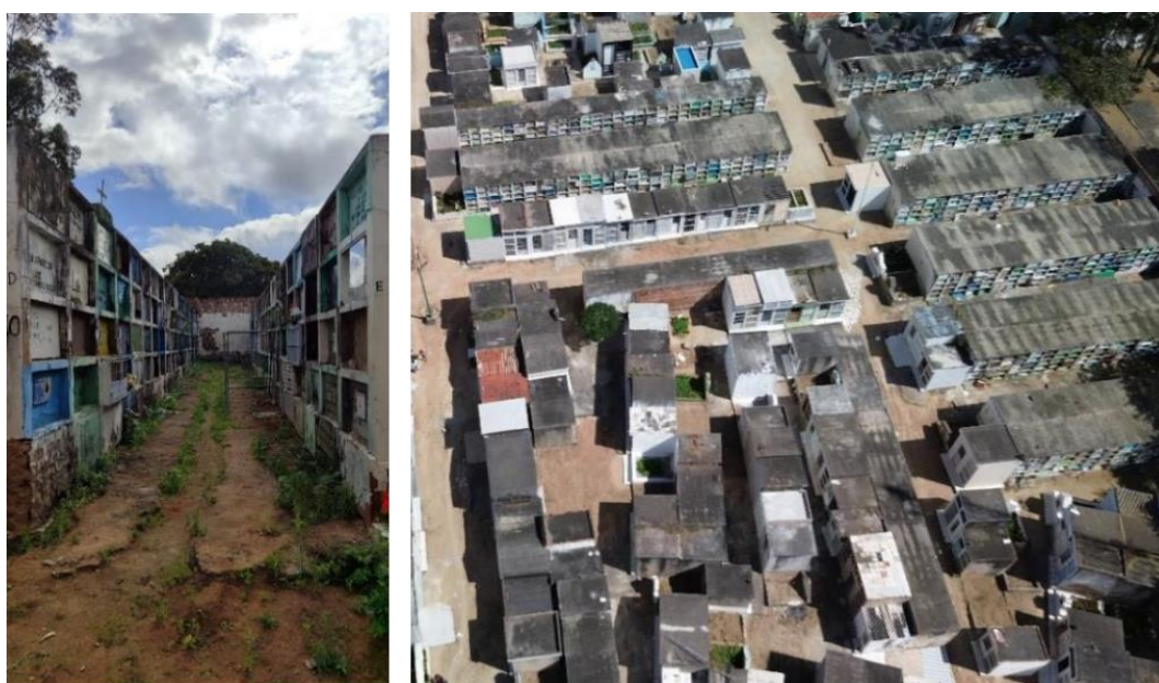
Figura 02: Corredores sem saída formado por gavetas funerárias (esquerda) e vista superior das ruas formadas pelos volumes de gavetas funerárias (direita). Fonte: Registrado pelo autor, 2025
