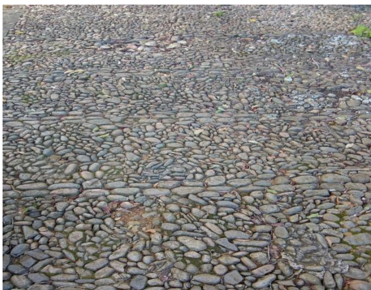
Figura 6 – Calçamento na área detrás da capela
