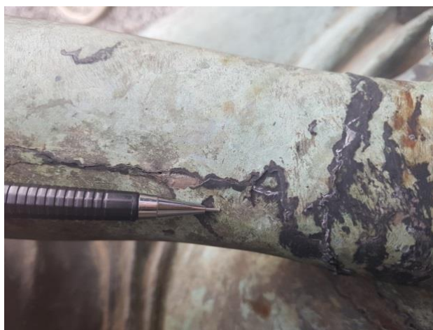
Figura 15 – Detalhe do deslocamento em região de solda
