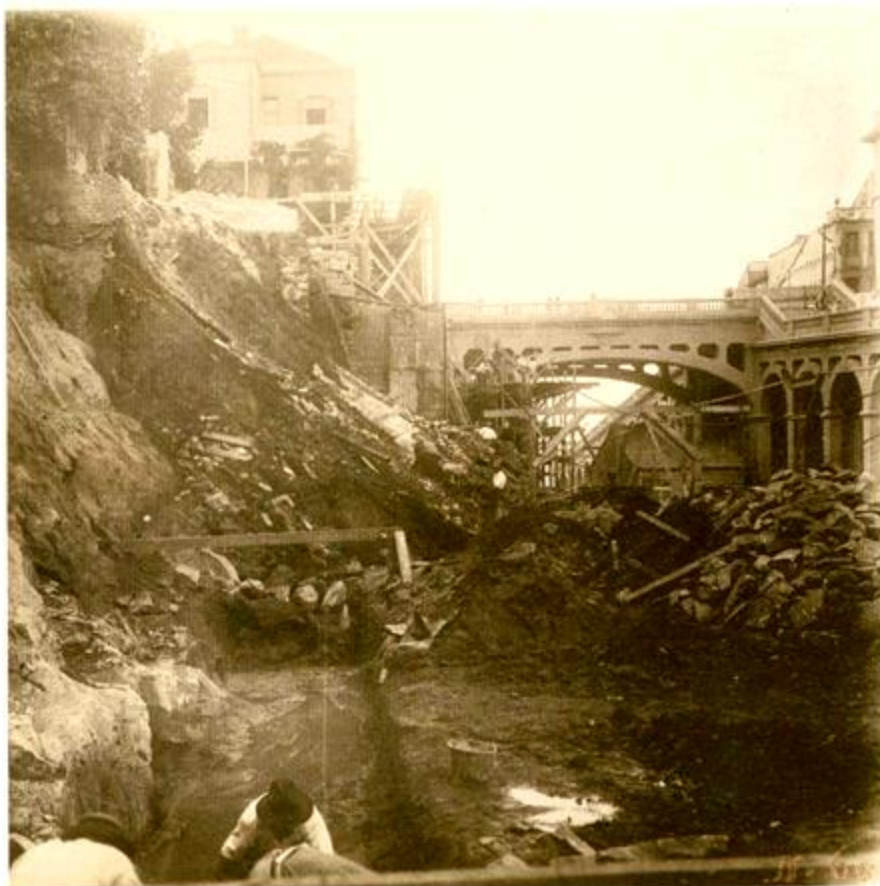
Figura 7 – Construção da Avenida Borges de Medeiros
